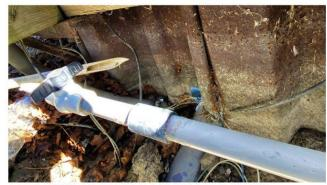
BROKEN DUCT FOR POWER LINE FEEDS TO POWER
